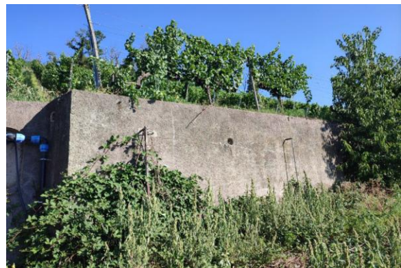
Foto 2: Betonmauer am Plangebietsrand vor der Umgestaltung zur Trockenmauer, darüber Weinbau.
